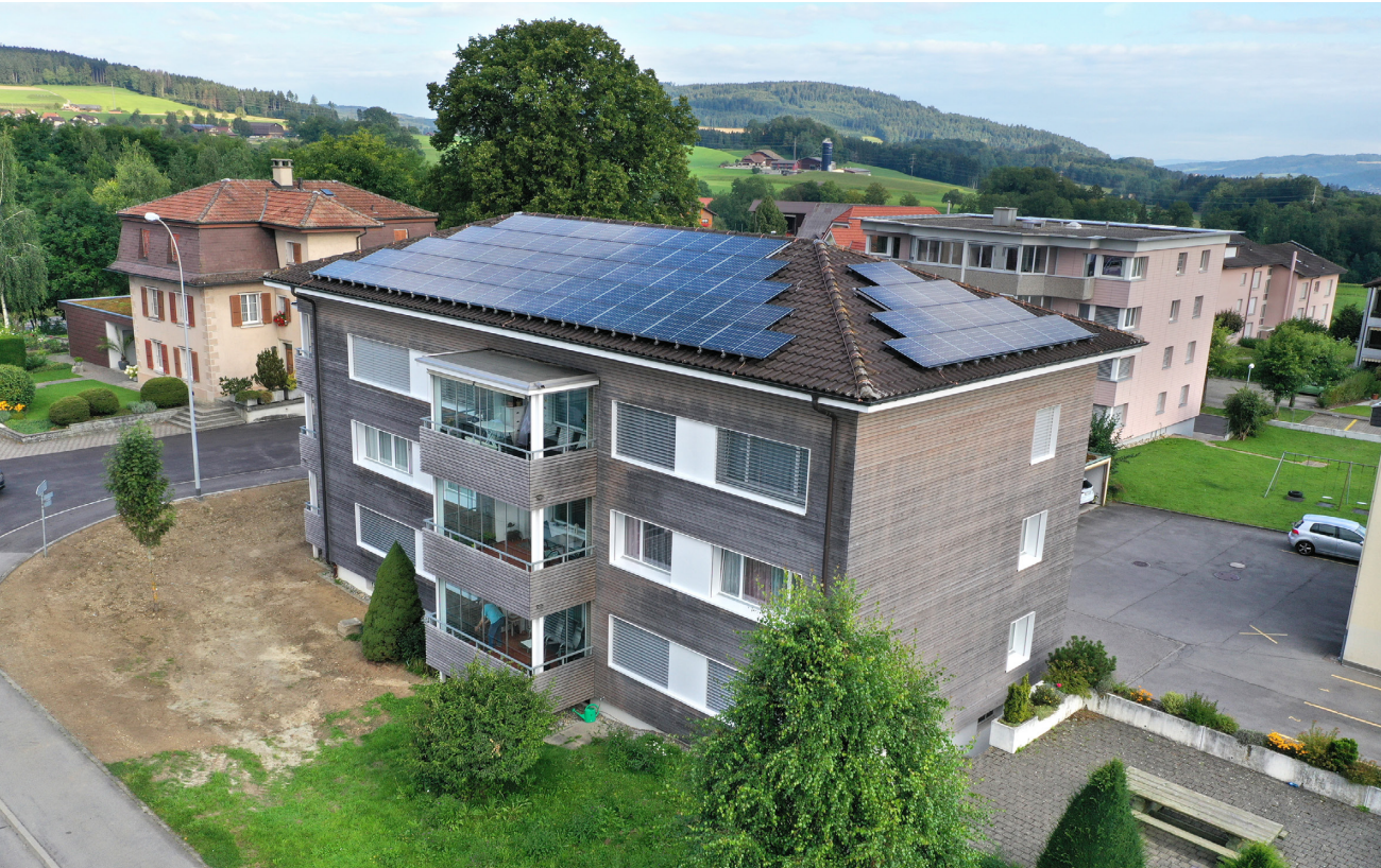
Nach der umfassenden energetischen Sanierung und der Installation von Photovoltaik-Modulen auf dem Dach ist das über fünfzigjährige Mehrfamilienhaus Schützelfeld 1 wieder fit für die Zukunft. Bild: alsona ag – Energiekonzepte und Solar (8. 2021)
