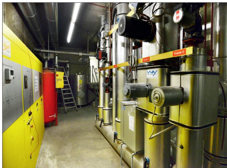
In zwei Heizkesseln, die mit hoch funktionalen Filteranlagen ausgerüstet sind, wird durch emissionsarme Verbrennung Wärme erzeugt, die über Rohrleitungen von insgesamt ca. 5 Kilometer Länge in die Häuser gelangt. Der Winter kann kommen! (Bilder: © Fernwärmeverbund Beromünster AG)
